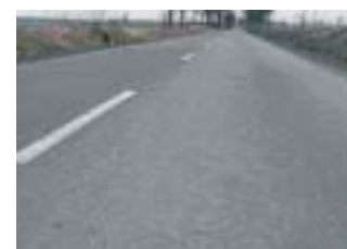
Több mint 20 ezer tonna martaszfalt került vissza az útburkolatba – larekás helyett
